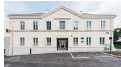
Sanierung Tulln, Wohnungseigentümer: © NÖ Wohnbaupreis 2016
